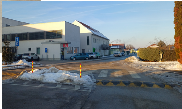
Slika 12: Vzpostavljen prehod za pešce in umiritev prometa pred občinsko stavbo s hitrostnimi ovirami, Dornava, vir: Google maps
